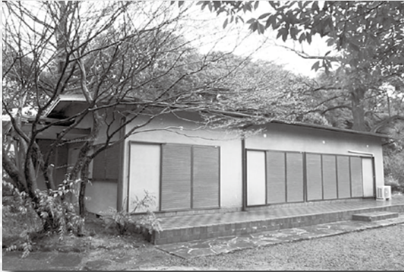
同窓会館全景
